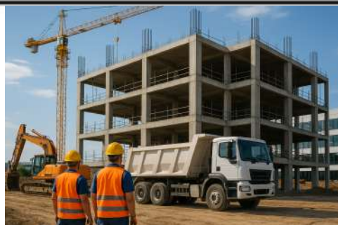
Foto 5-Caminhão basculante Construção de um Edifício Canteiro de Obra Limpo
