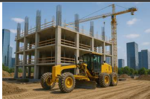
Foto 3-Moto niveladora Construção de um Edifício Canteiro de Obra Limpo
