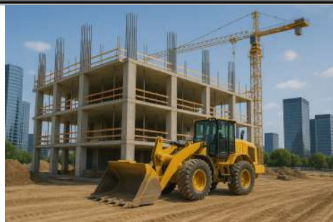
Foto 4-Pá carregadeira Construção de um Edifício Canteiro de Obra Limpo
