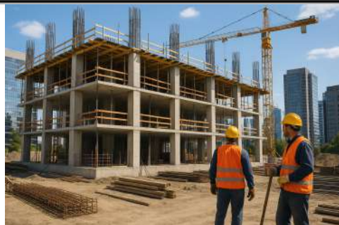
Foto 1-Operários na Obra Construção de um Edifício Canteiro de Obra Limpo
