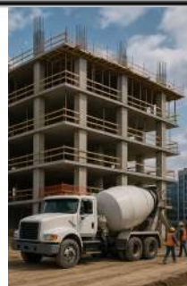
Foto 6-Caminhão de Concreto Construção de um Edifício Canteiro de Obra Limpo
