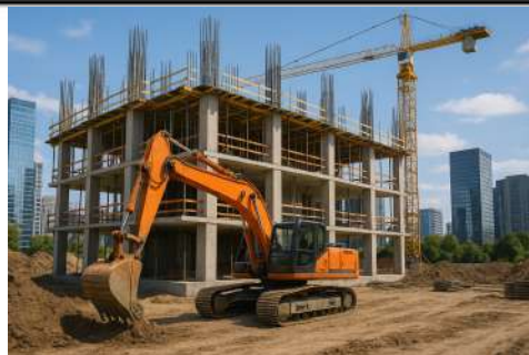
Foto 2-Escavadeira Construção de um Edifício Canteiro de Obra Limpo
